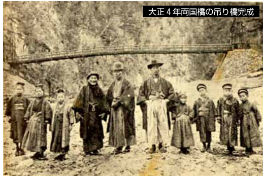
大正4年両国橋の吊り橋完成
