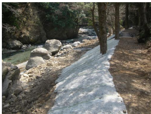
周辺の自然環境に配慮した植生ネットの利用（整備直後）
