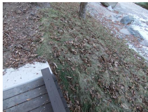
周辺の自然環境に配慮した植生ネットの利用（整備後）
