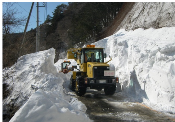
大雪の除雪作業の状況
