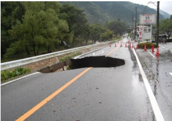
台風による国道413号の陥没
