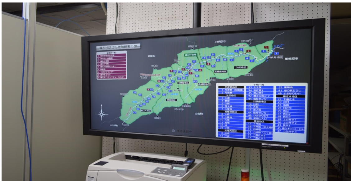
防災行政無線 大型地図表示盤
