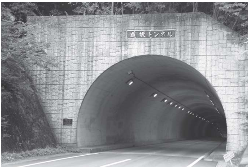
道坂トンネルを下げて建設を
