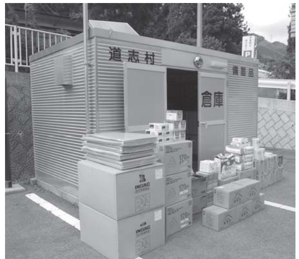
備蓄倉庫の非常食交換は定期的に
