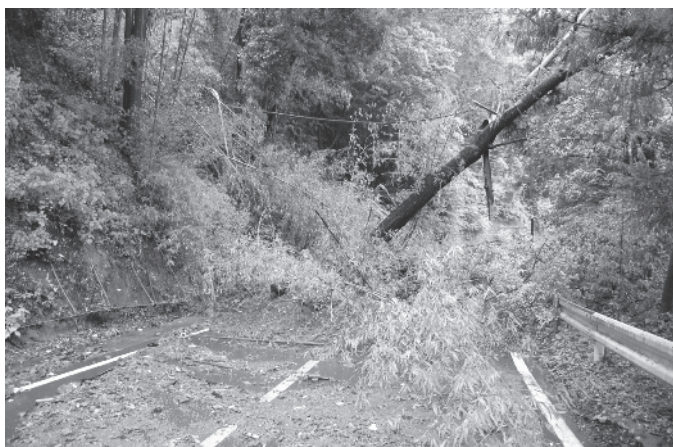
土砂崩落 (国道 413 号月夜野地内)
