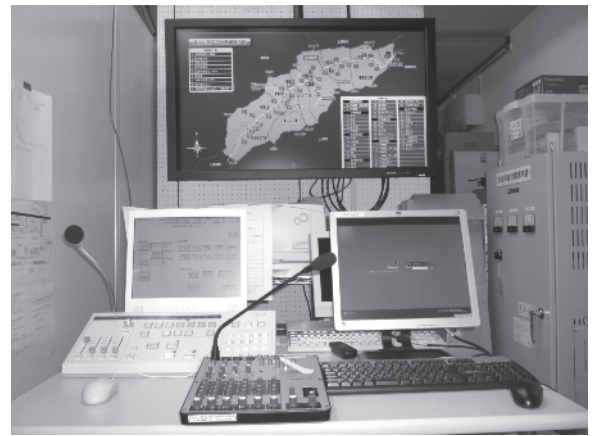
防災無線放送設備
