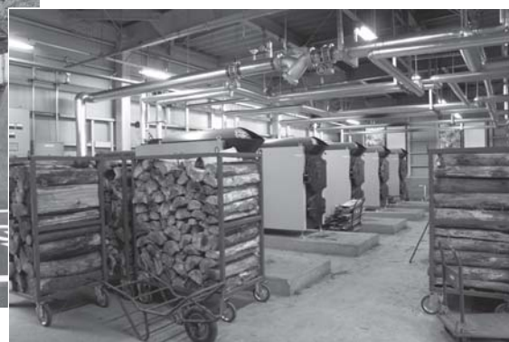
薪ボイラー施設
