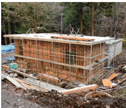
工事中の白井平配水池
