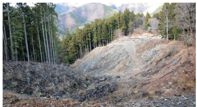
田代残土処理場
