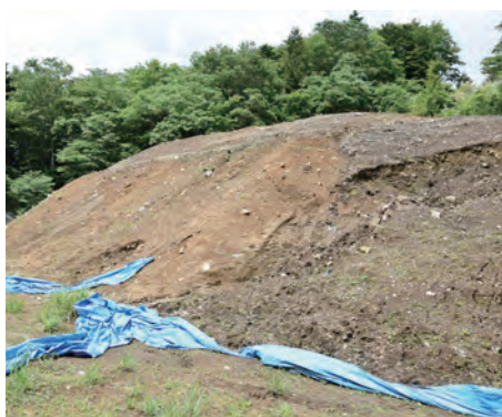
残土処理場の状況
