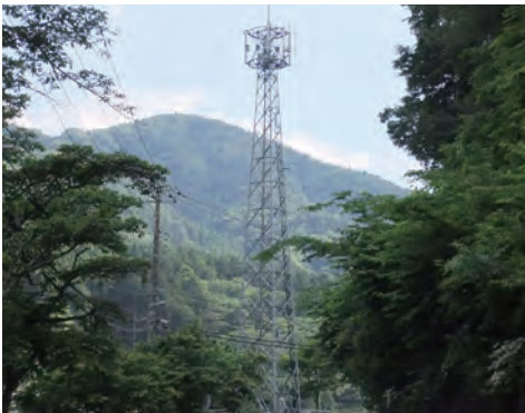
設置してある電波塔
