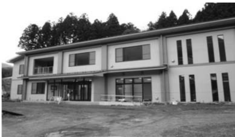
「水源の郷 やまゆりセンター」の外観 間もなく完成
