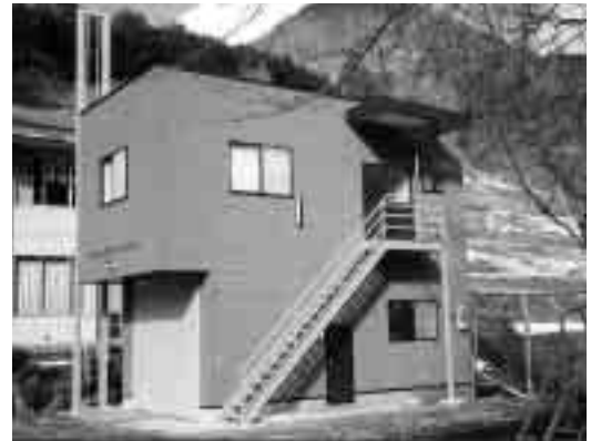
第一分団第二部詰所新築（久保地内）
