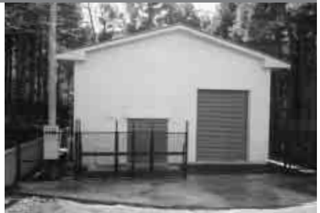
膜ろ過施設が完成（大渡地内）
