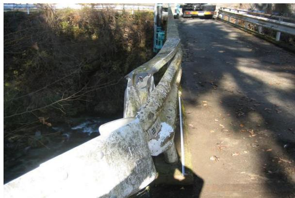
(高欄の腐食および変形)
