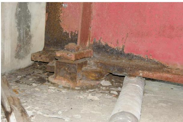
(主桁および支承の腐食)
